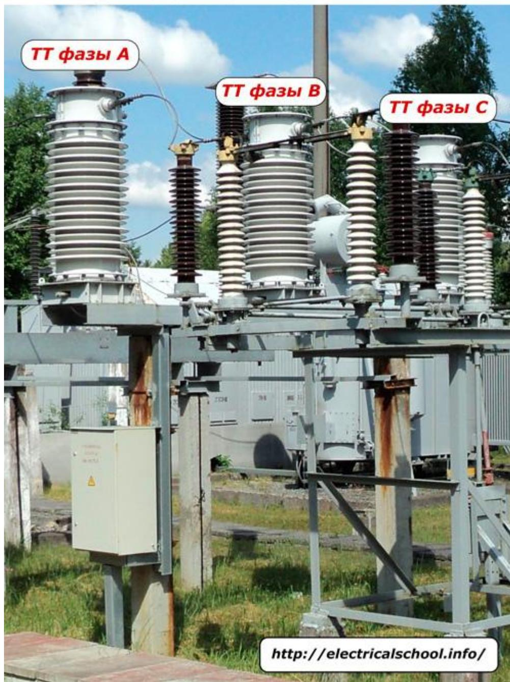
Эти же задачи выполняют трансформаторы тока на ОРУ-330 кВ, но, учитывая сложность более высоковольтного оборудования, они имеют значительно большие габариты.
