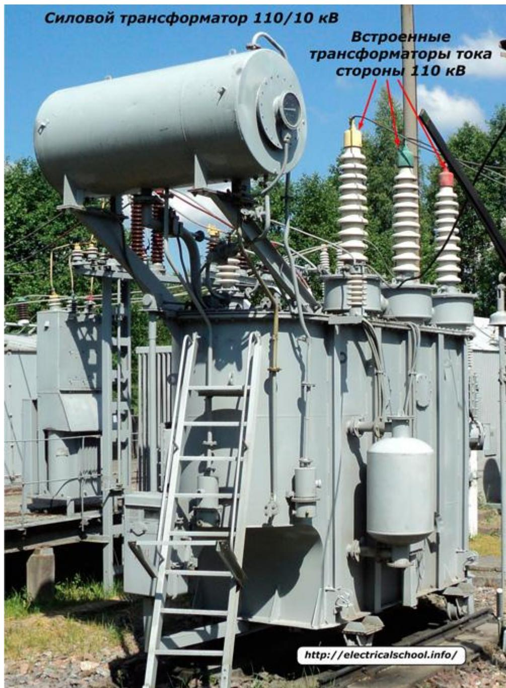
Они имеют вторичные обмотки с выводами, размещаемыми вокруг высоковольтного ввода в герметичном корпусе. Кабели от зажимов ТТ проложены к прикрепленным здесь же клеммным ящикам.
