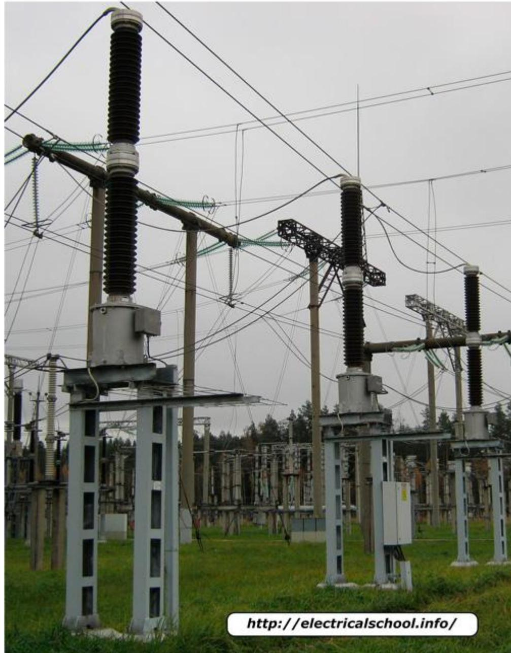
На энергетическом оборудовании часто применяют встроенные конструкции трансформаторов тока, которые размещают прямо на корпусе силового объекта.
