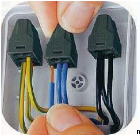
Рисунок. Зажимы для соединения жил проводов и кабелей электропроводки: а – клеммные зажимы; б – бугельный зажим; в – пружинный зажим
