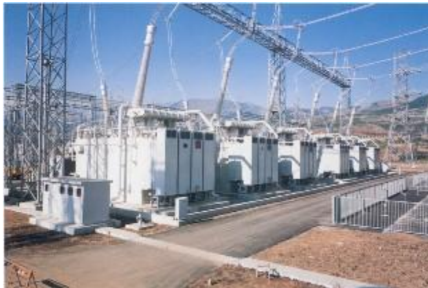
Высоковольтные автотрансформаторы
