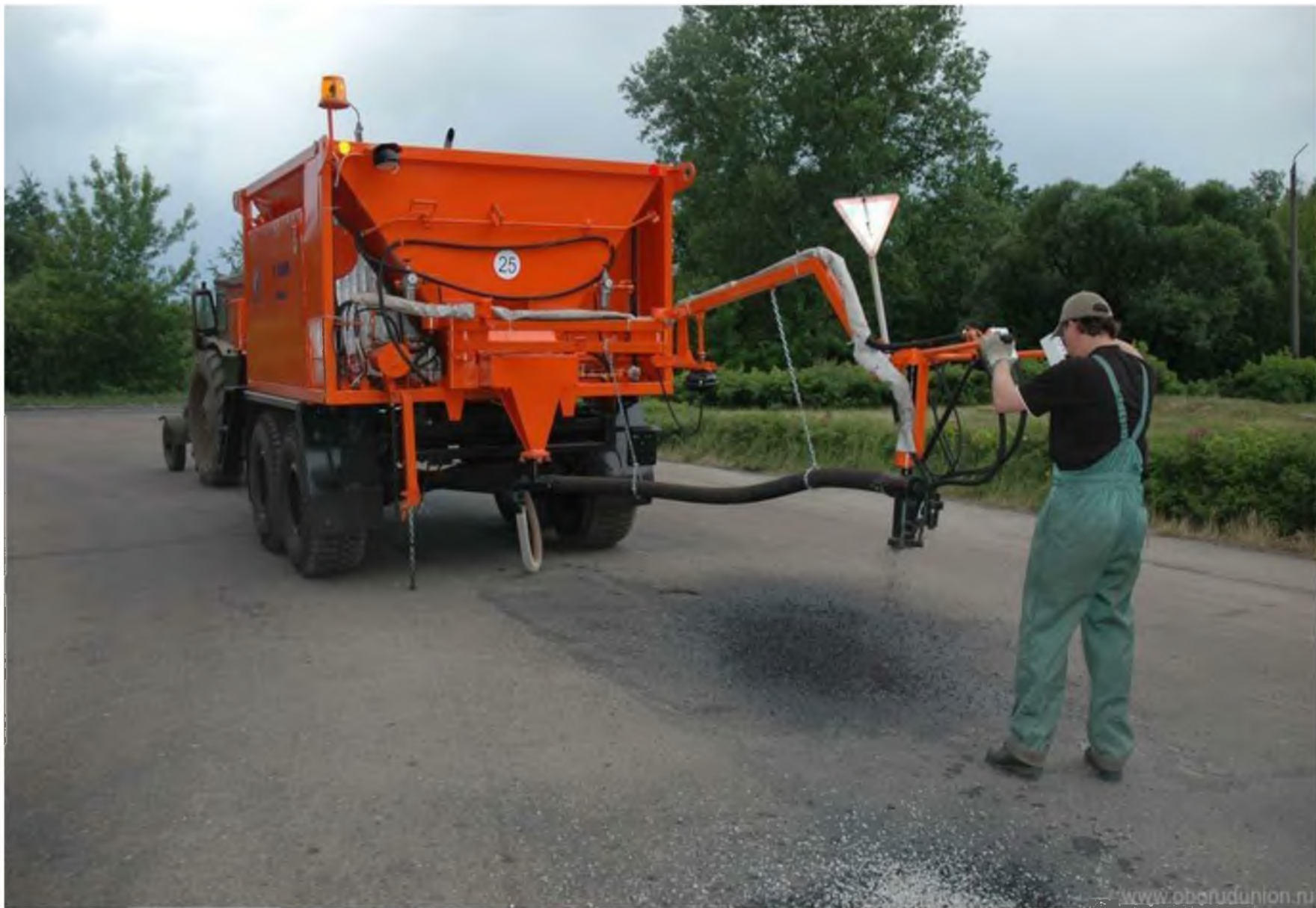
Машины для ямочного ремонта
