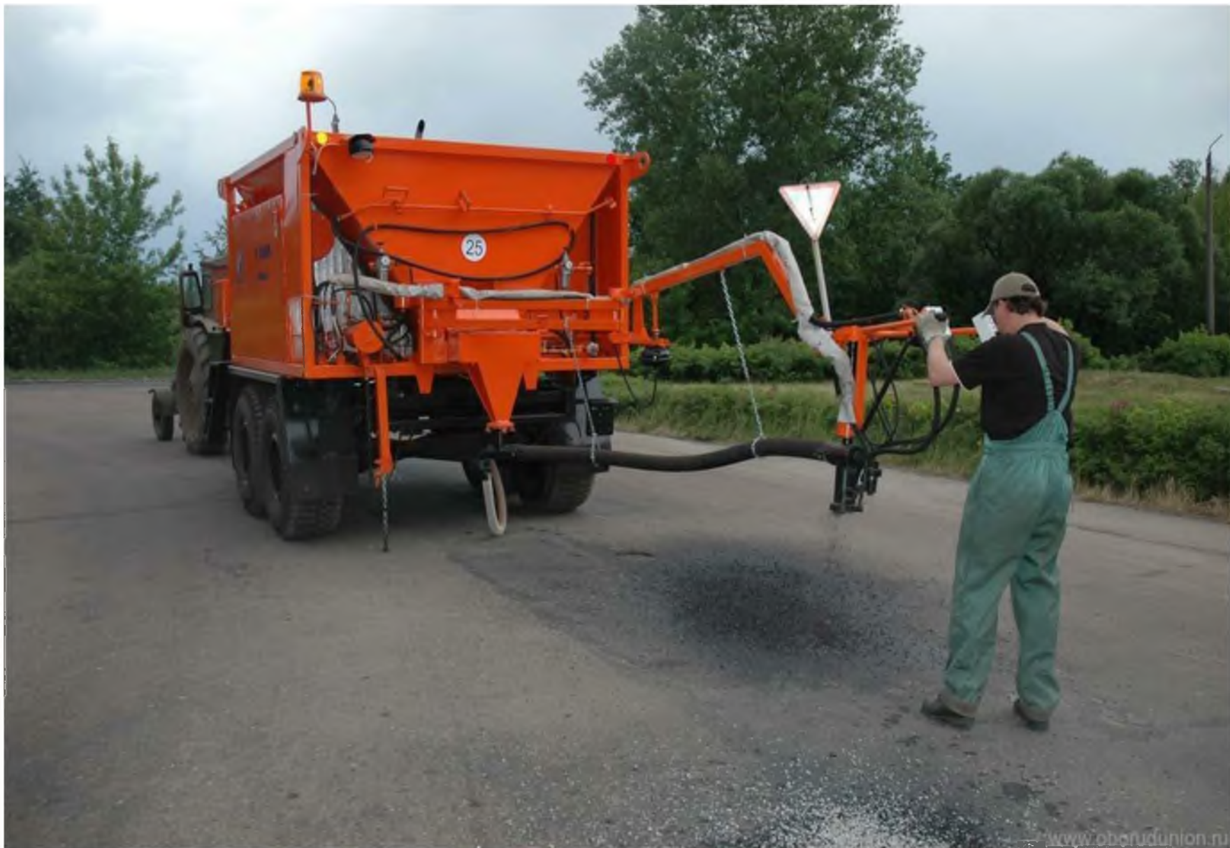
Машины для ямочного ремонта
