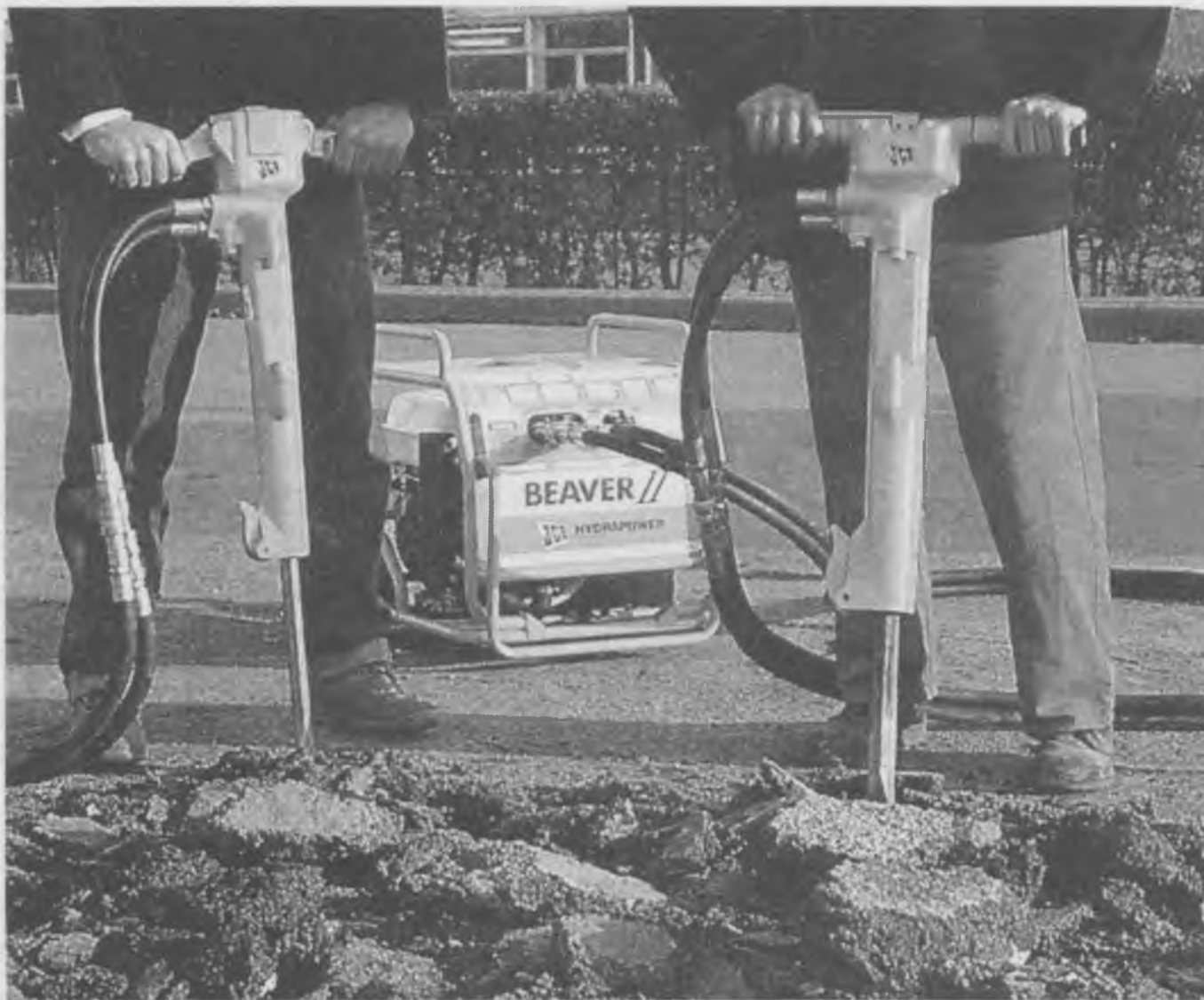
рис. 4.11. Работа маслонасосной установки с двумя отбойными молотками
